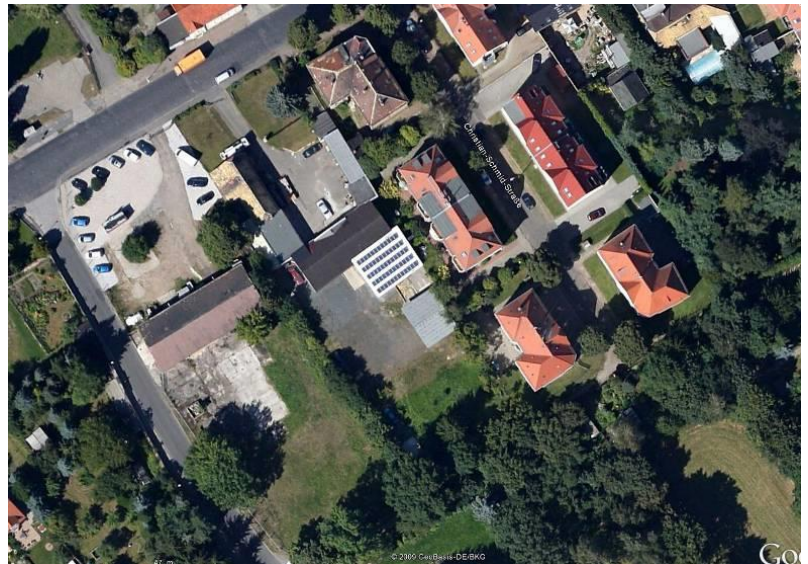
Luftbildaufnahme mit Kennzeichnung der Lage des Grundstücks und Gebäudebestand vor Beginn der Rückbau- und Abbrucharbeiten
