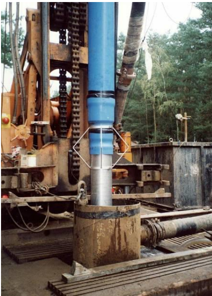
Einbau neues PVC-Vollrohr/Edelstahlwickeldrahtfilter mit Zentrierung
