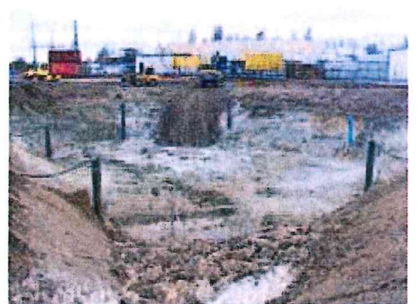
Tiefenaushub Tanklager LMT III
