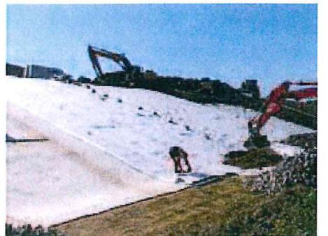
Verlegung Bentonitmatten
